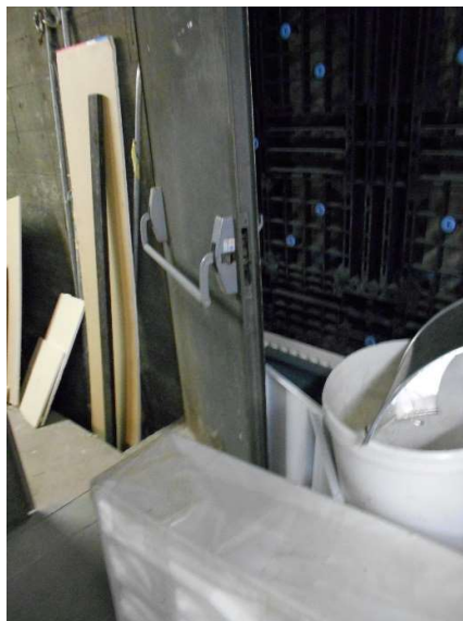
Sortie de chaufferie obstruée
