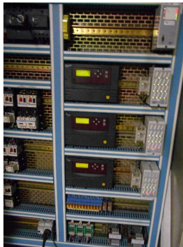
Régulateur pour les circuits du 105
